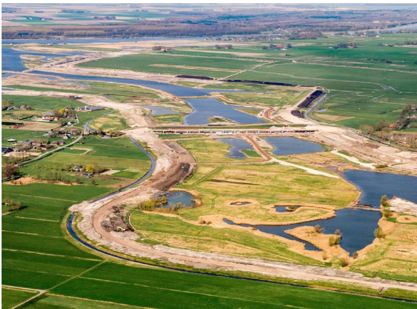
Het Reevediep en de klimaatdijk in aanleg
