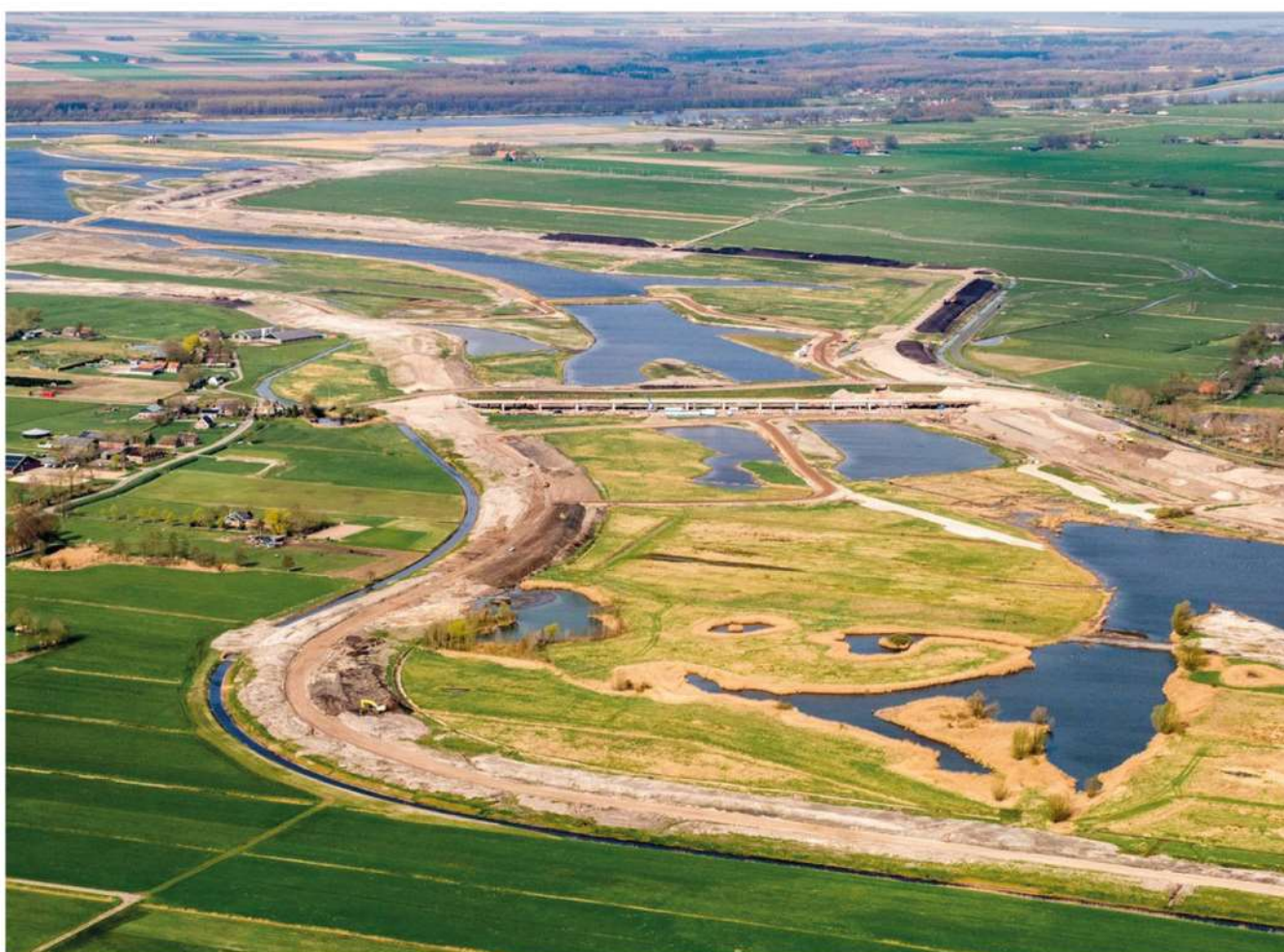
Het Reevediep en de klimaatdijk in aanleg
