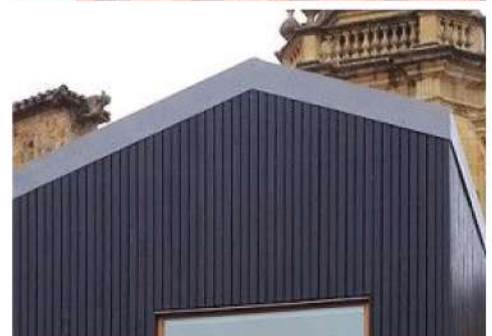
Als alternatief kunnen dakranden juist worden aangezet. De rand wordt een eigen vlak of ornement dat laat zien van welk materiaal het is gemaakt. De dakrand ligt in dit geval ook vlak in de gevel
